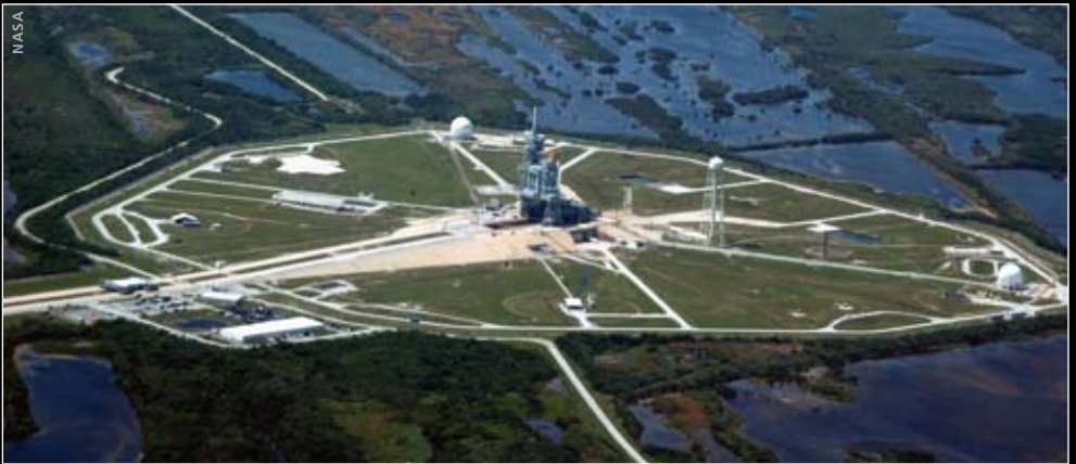
STS-114: Luftaufnahme der Startanlage 39B, von der die Discovery gestartet ist
