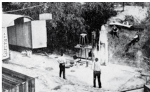
Prüfstand des Raketenflugplatzes Berlin 1933 mit Vierstab-Repulsor.
